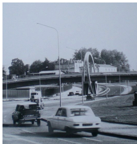
Passerelle reliant le campus Bordes et Peixotto - archive universitaire de 2008 © Université de Bordeaux
